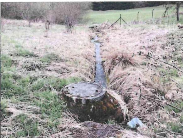
*Das begradigte und ausgebaute (Sohlschalen) Langentalbächle im Plangebiet, das in einem Schacht endet.*
